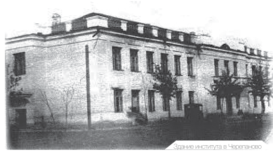
Здание института в Черепаново
